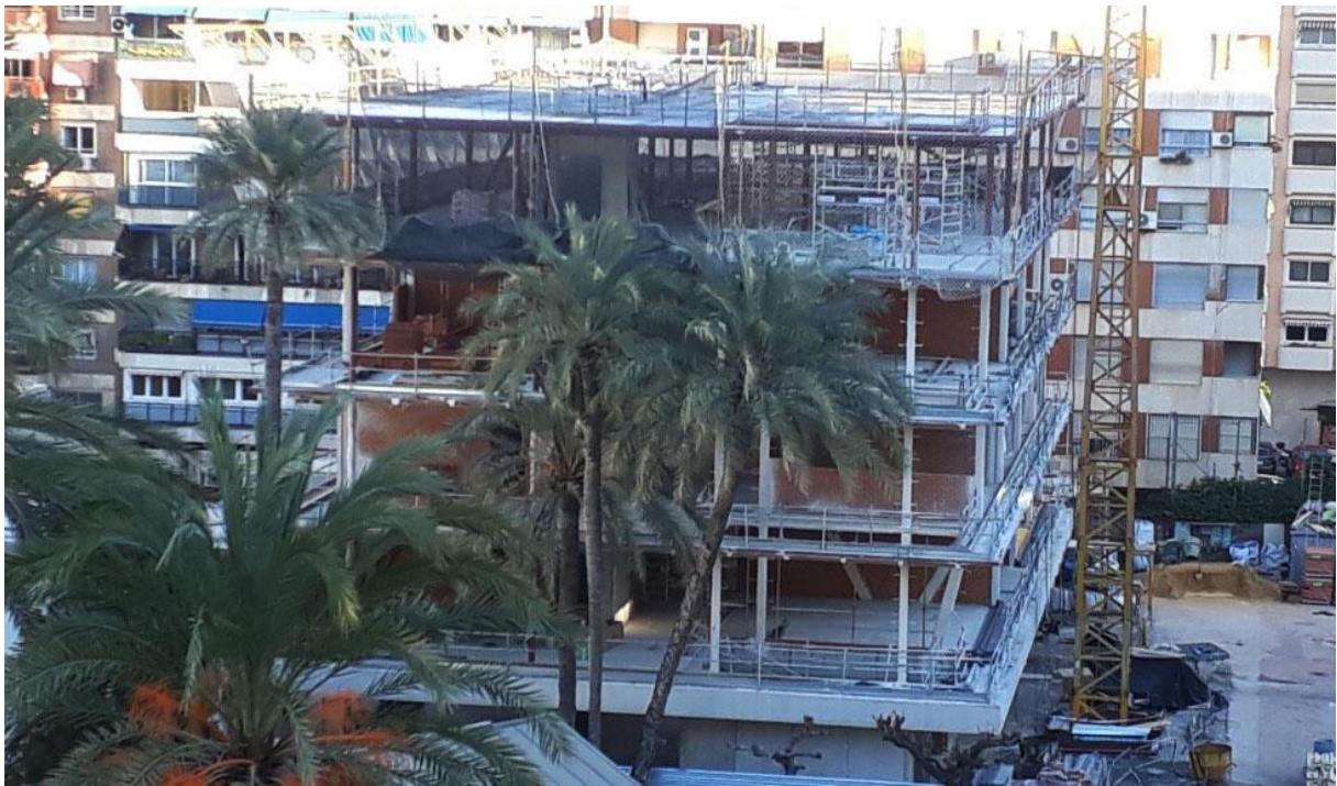
Fortschritt der Bauarbeiten des neuen Gebäudes der Sekundaria.
