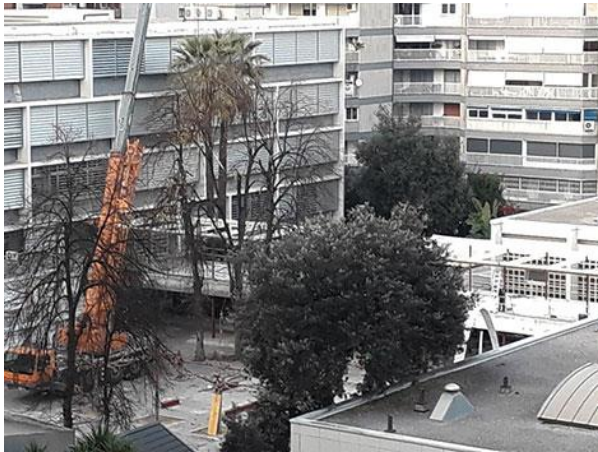
Kran zum Transport und Befestigung der Überdachung des Verbindungsgangs
