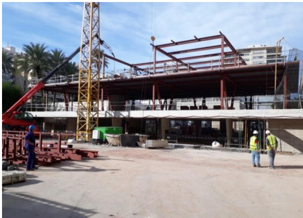
Grundstruktur des neuen Gymnasialgebäudes der DSV
