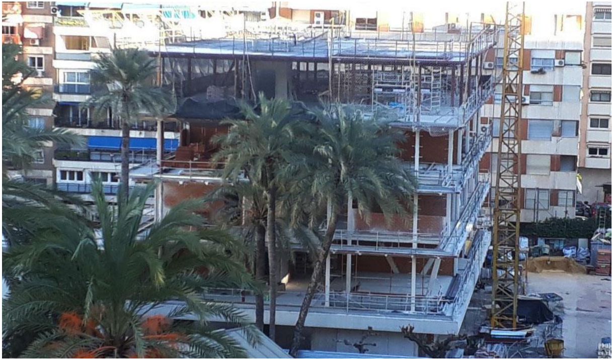
Avances de las obras en el nuevo edificio de secundaria.
