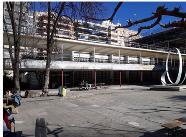
Aspecto actual de la futura pasarela
