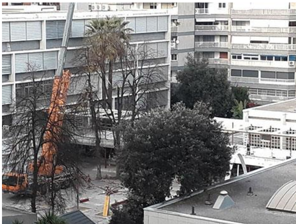
Grúa montando la estructura de la cubierta de la pasarela
